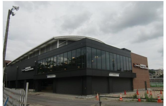
（開業準備が進む「羽沢横浜国大駅」）
